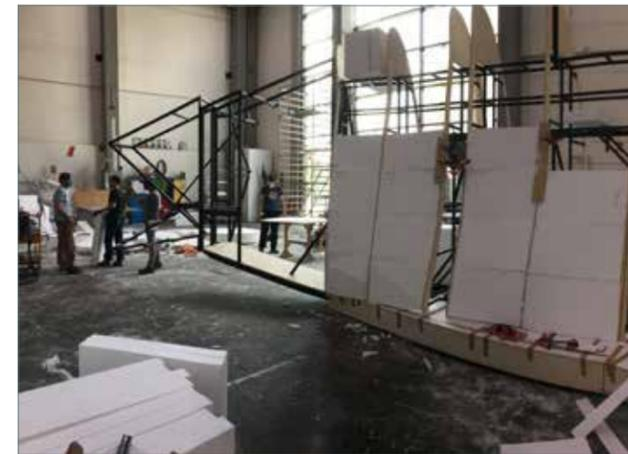
Mit Fachwerk verschraubte Stahlböcke und gefräste Holzspanten an diesen ergeben die Außenkontur des Fisches. Fotos: Monika Pormale [3]
